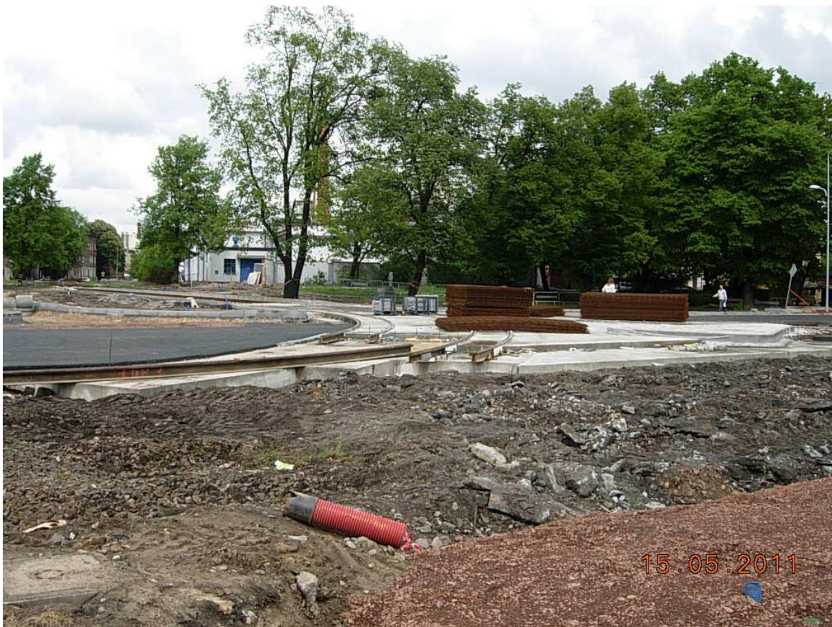
Montaż rozjazdów na skrzyżowaniu ul. Królowej Jadwigi i Marszałka Focha. Foto. Stanisław Sitarek
