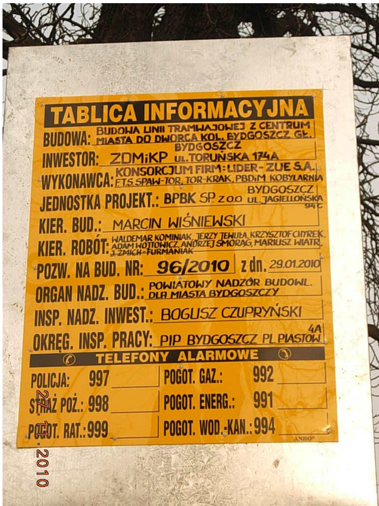
Tablica informacyjna budowy linii tramwajowej do dworca Bydgoszcz Główna.
