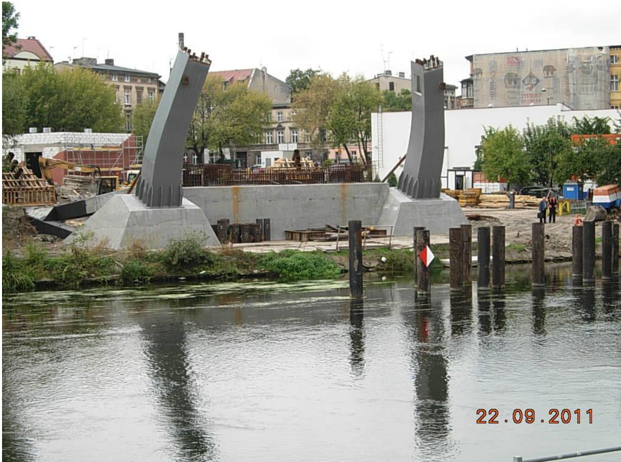
Budowa południowego przyczółka mostu tramwajowego. Foto. Stanisław Sitarek
